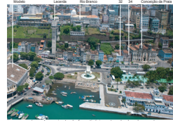
Imagem aérea do conjunto do frontispício antes do desabamento. Fonte: Roberto Costa
